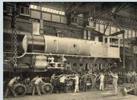
Usine de la SACM de Belfort atelier de montage des locomotives à vapeur, début du XX e siècle (coll. Archives municipales de Belfort)
