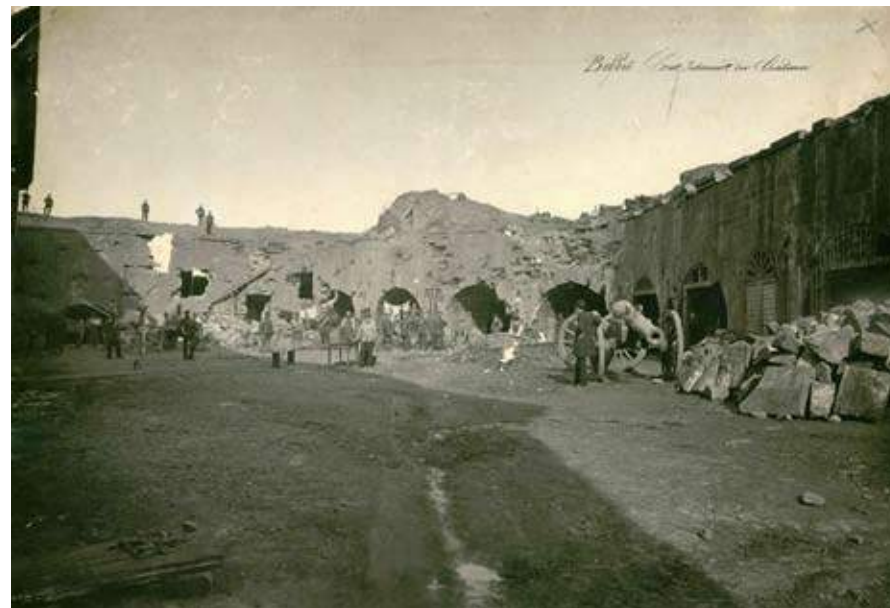
▲ Destructions lors du siège de 1870-1871 Cour d'honneur de la citadelle de Belfort Carte postale Coll. Archives municipales de Belfort
